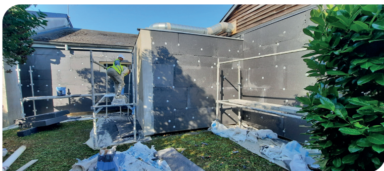
Isolation par l'extérieur de l'école de Hanches
