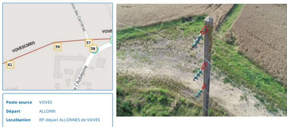
Exemple support 59, remplacement des étriers et œillets entre 25 et 50% d'usure.
