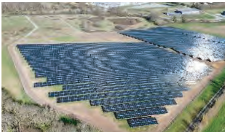
Centrale au sol de Nogent-le-Rotrou
