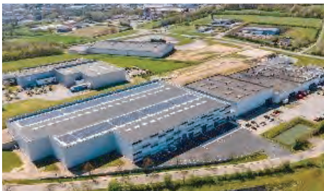
Installation sur toiture sur le site de la société Eurowipes
