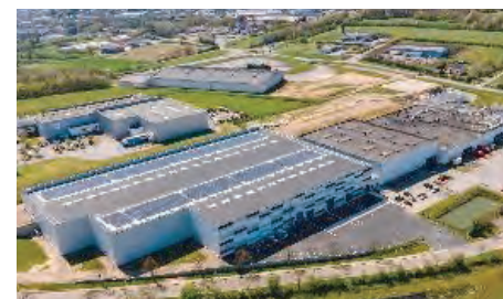
Installation sur toiture sur le site de la société Eurowipes
