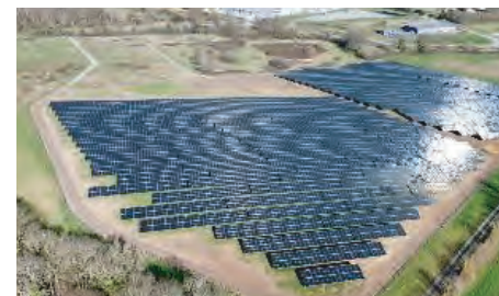
Centrale au sol de Nogent-le-Rotrou
