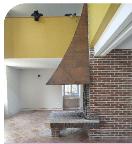
Val-d'Yerre Rénovation globale du Moulin
