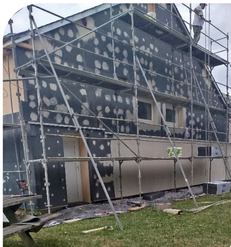
La Framboisière Isolation extérieure de l'école
